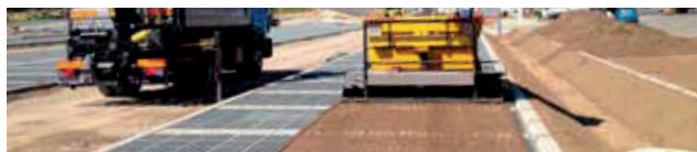
Wprowadzenie wypełnienia za pomocą rozścielacza drogowego
