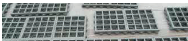
Ułożenie elementów TTE® na podłożu drobnym
