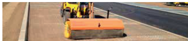
Utworzyć warstwę wypełnienia za pomocą zmiataarki
