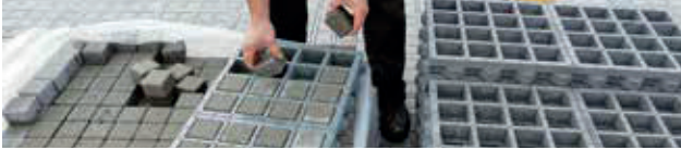
Montaż/ układanie kostek brukowych do kraty TTE®
