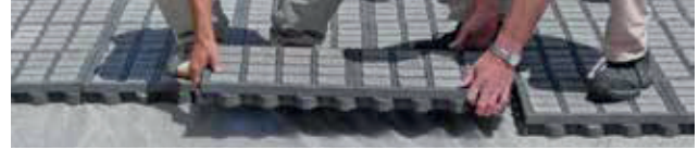
Układanie wypełnionych elementów TTE®
